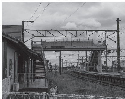
三股駅跨線橋
