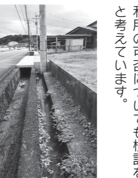
勝岡蓼池線沿道の排水路(左側)と用水路(右側)
