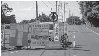
全面通行止め箇所
