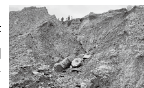
盛土が崩落し流失した土砂
