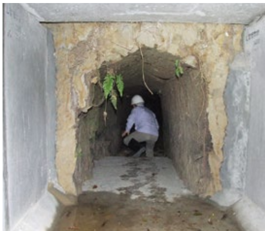
↑手掘りとコンクリートの境部①
