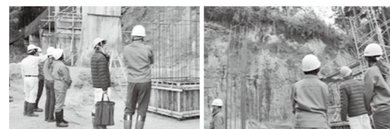
福留水路橋の復旧工事現場① 福留水路橋の復旧工事現場②
