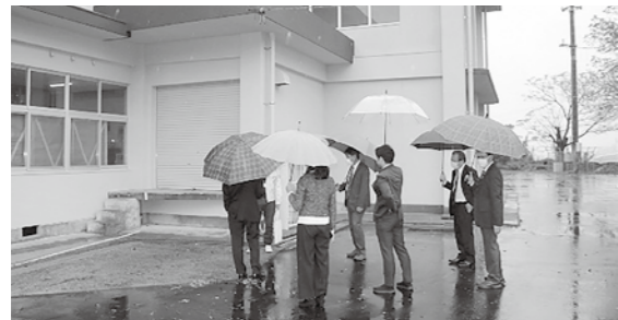
宮村小学校外壁改修・防水工事
