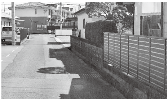
ふくよし南側町道の側溝
