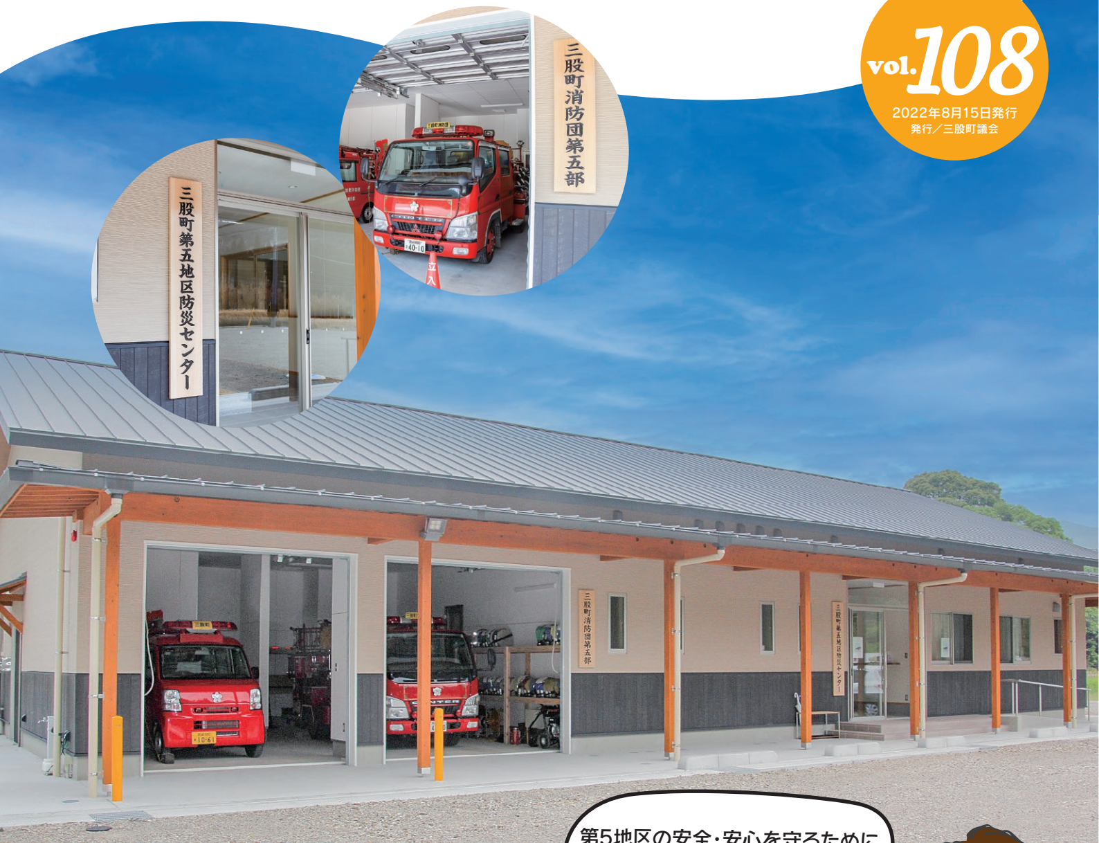
photo: 第5地区防災センター
