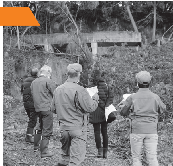
崩壊した福留水路橋
