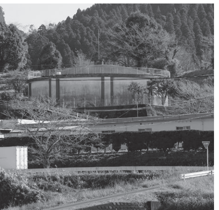
上米公園東側の配水池
