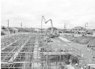
▲建設中の東原住宅B棟
