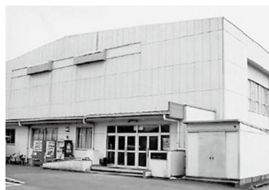
勤労者体育センター耐震補強・改修工事も含まれます。
