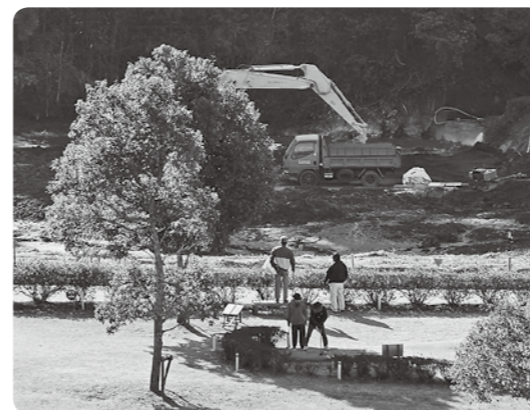
▲パークゴルフ場の増設現場の様子
