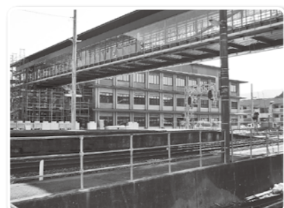
▲ 建設中の四万十町庁舎
