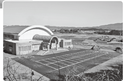
舗装整備がされた6地区分館
