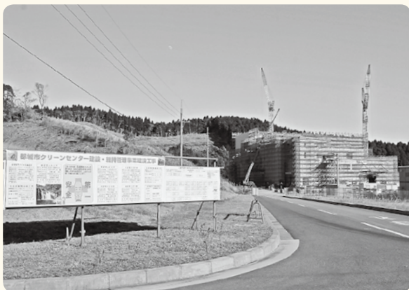
建設中の山田町清掃工場
