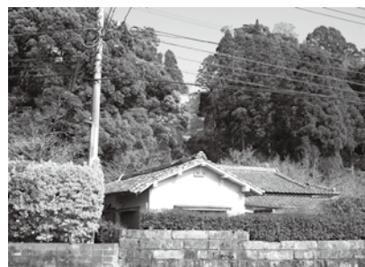
勝岡城跡西側斜面崩壊部補強事業 2千494万円 勝岡城跡西側斜面の補強保護
