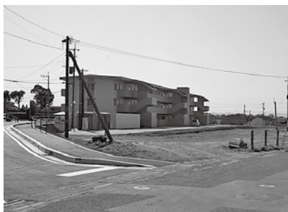
塚原第2団地建替事業 6億4561万円 B棟、3階建て41戸の建設
