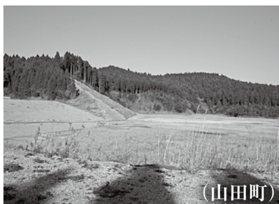
クリーンセンター建設事業 1304万円 新しい清掃工場建設準備 (山田町)
