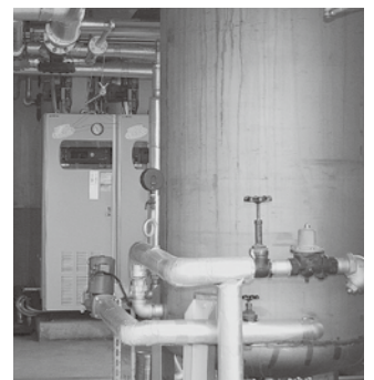
古くなった給食センターボイラー
