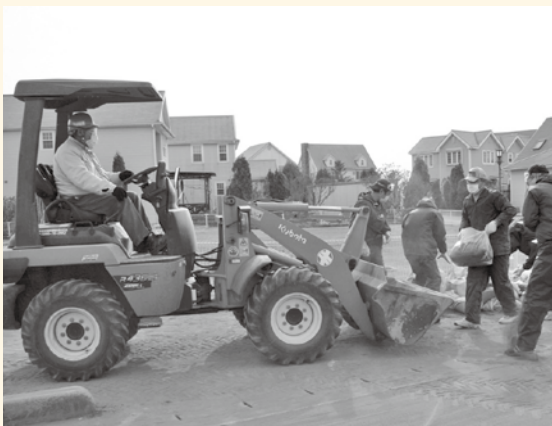
降灰除去作業
