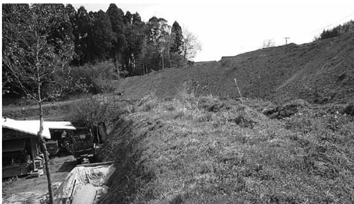
勝岡小北側の土地造成地
