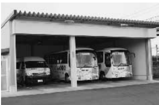
三股駅西側に完成したクイマール車庫
