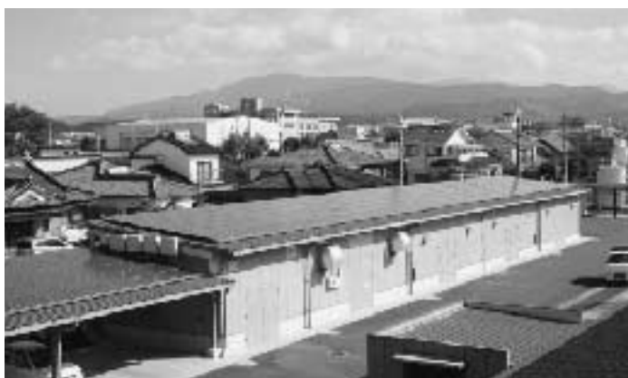
元気の杜に設置された太陽光パネル
