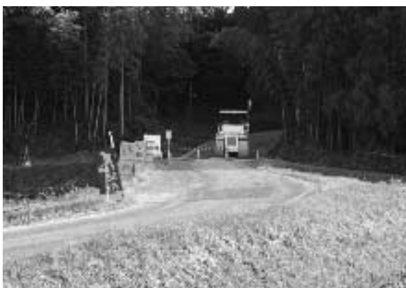
小鷲巣の道路維持工事
