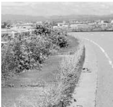
雑草で通行困難となった歩道
