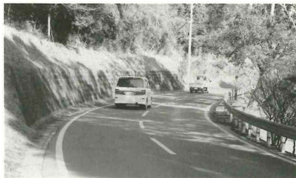
歩道のない県道(轟木)
