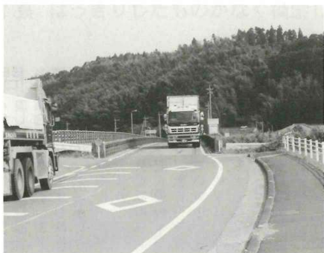
岩下橋の現状
