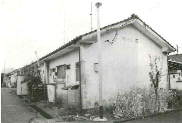
老朽化のすすむ町営住宅
