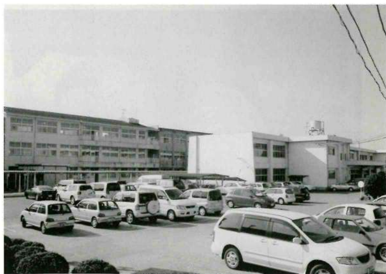
老朽化が進む中学校校舎
