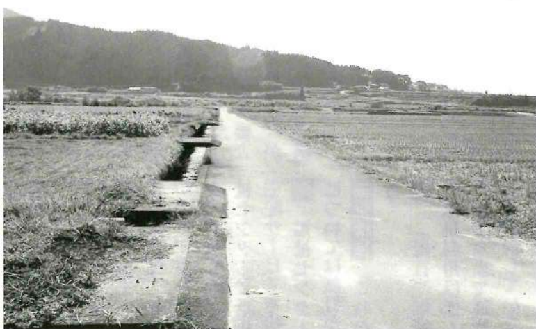
大雨時に、心配される排水路
