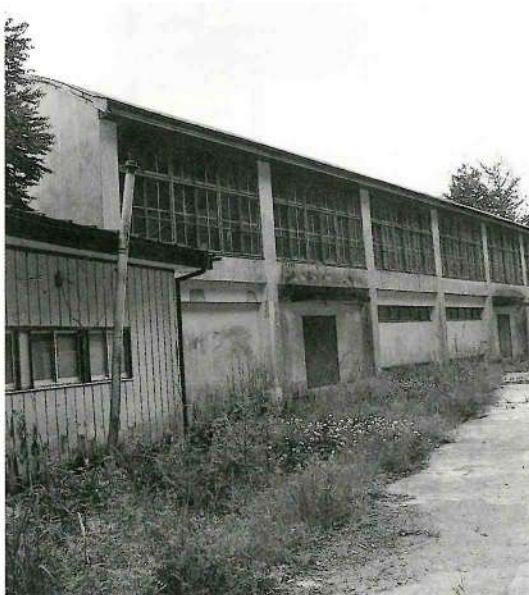
▲老朽化が進む長田小体育館
