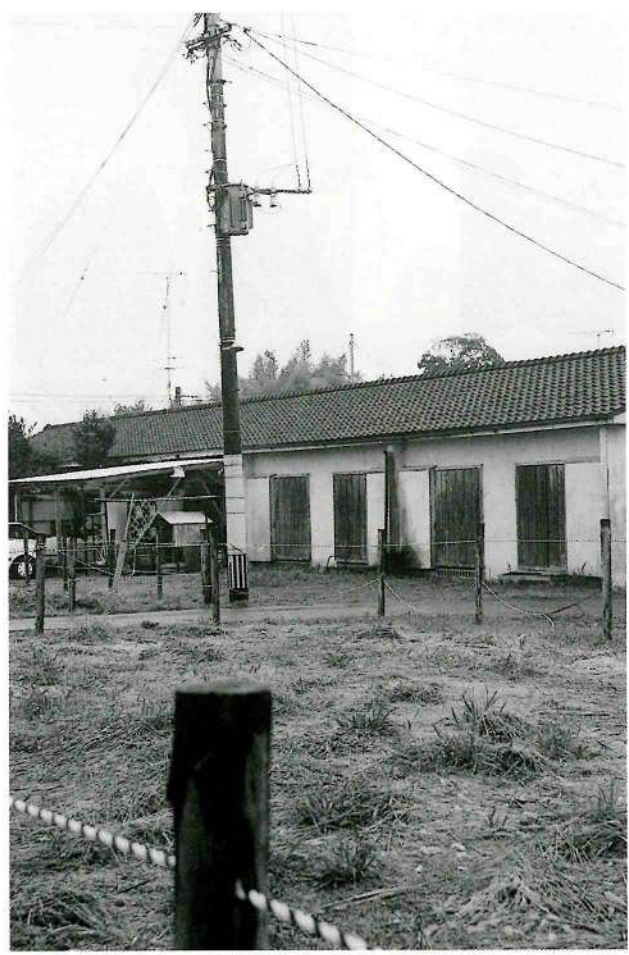
▲空家が目立つ町営住宅、手前の空地は解体された跡
