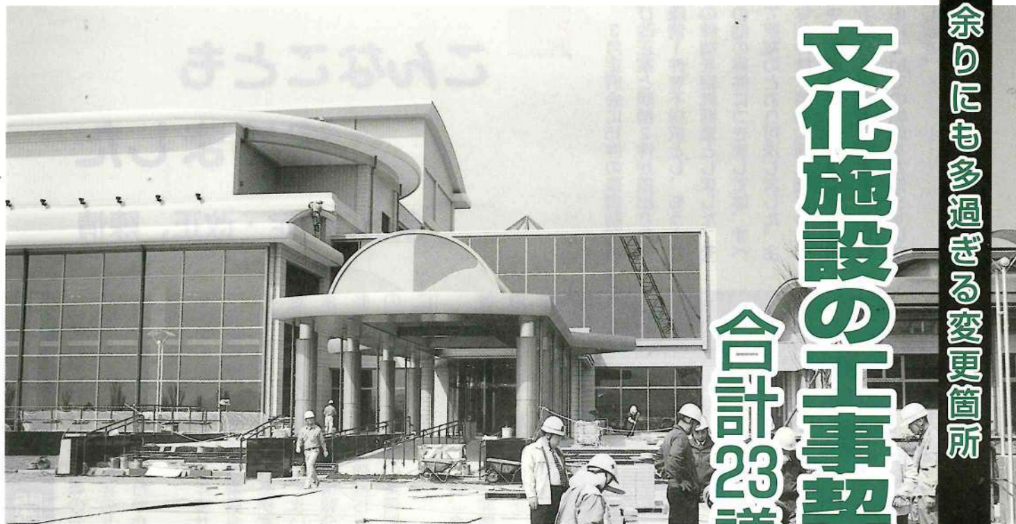
▲完成間近の文化ホールと図書館（撮影日：3月21日）
