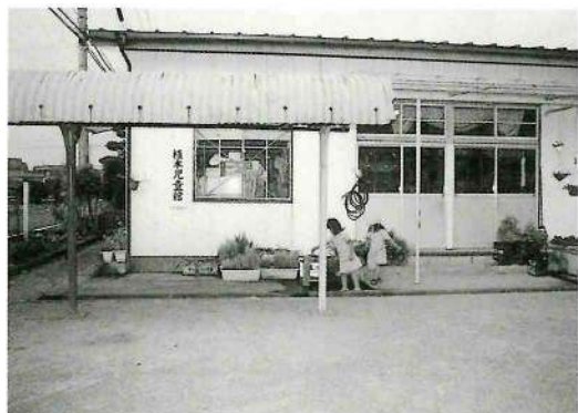
▲住宅密集地帯に建つ植木児童館、老朽化が進む。
