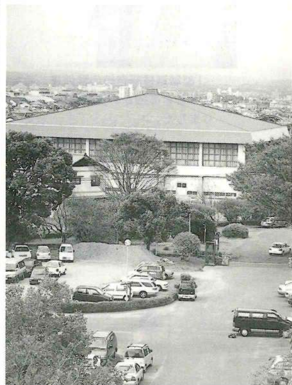
屋根葺き替え予定の武道体育館
