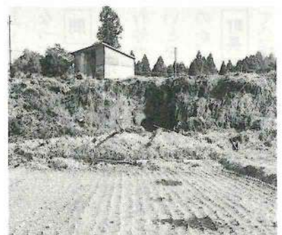
早期復旧が望まれる災害現場
