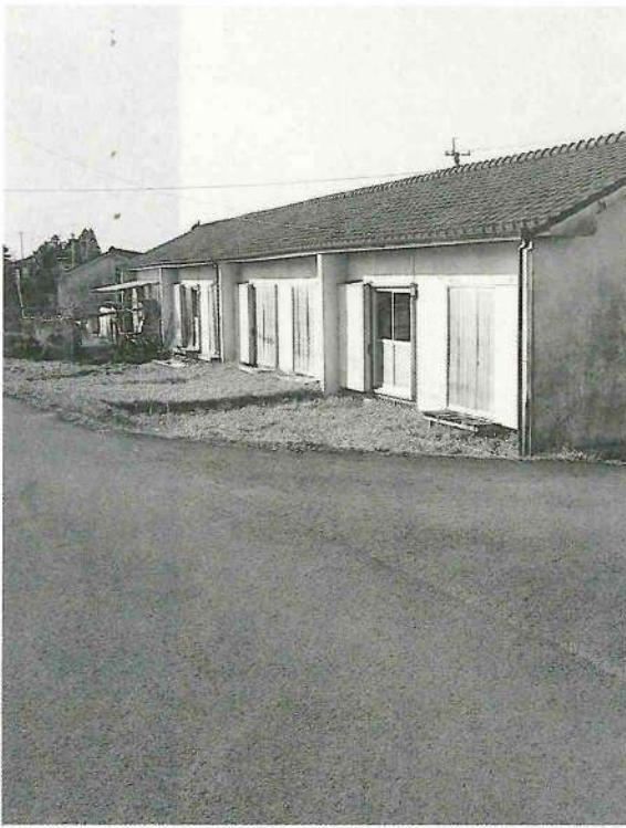
空き家が目立つ町営住宅
