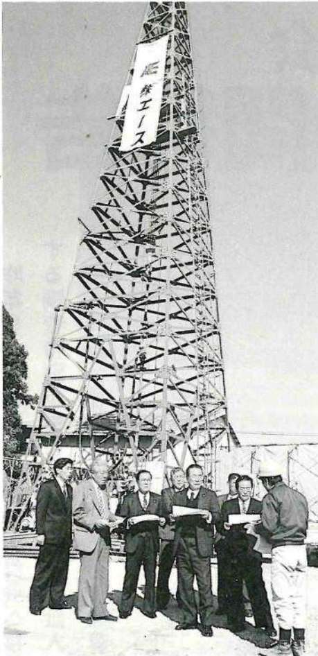
順調に進む温泉掘削
