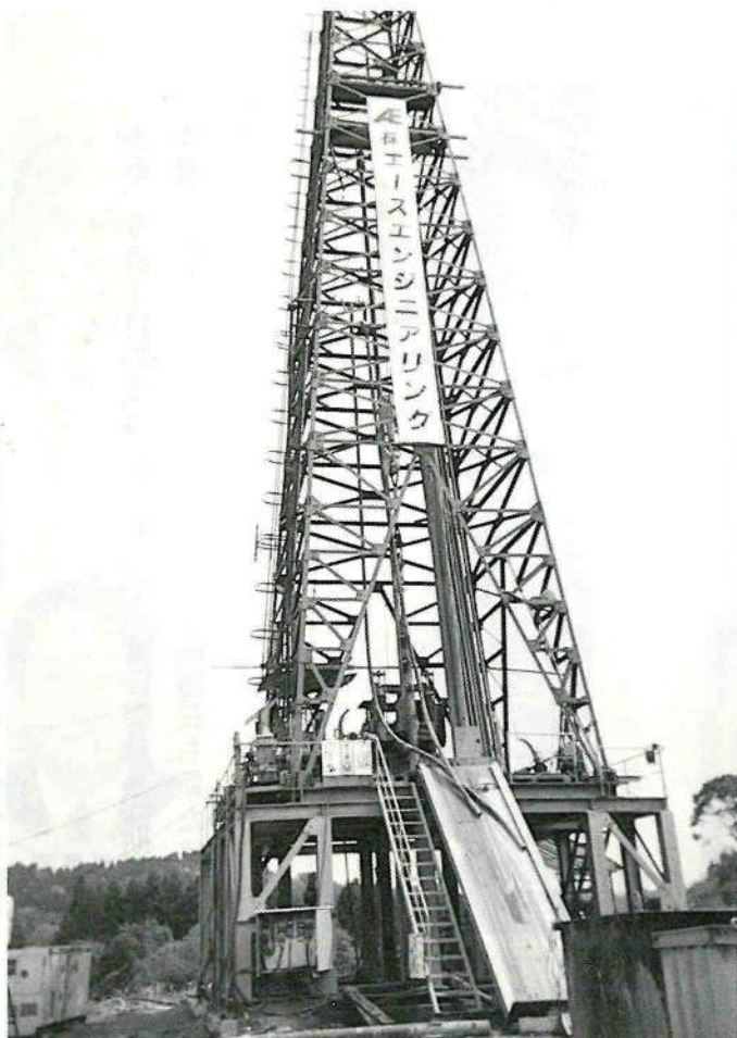
温泉掘削風景
