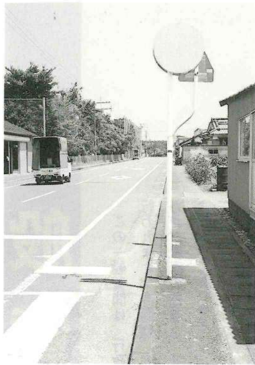
文字が消えている消火栓の標識
