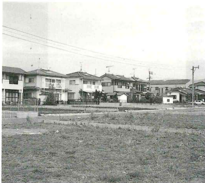
住宅の建設が続く植木地区
