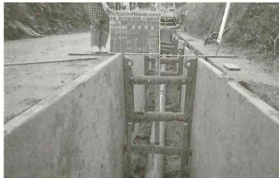
梶山農集排の工事風景
