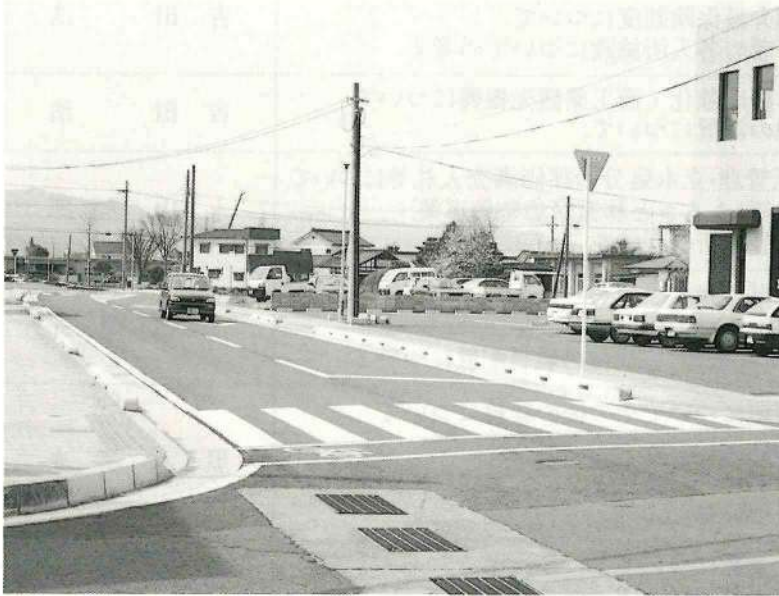
改良工事が進む三股駅小さぎす線
