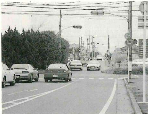
立体交差などの改良が待たれる桜木線
