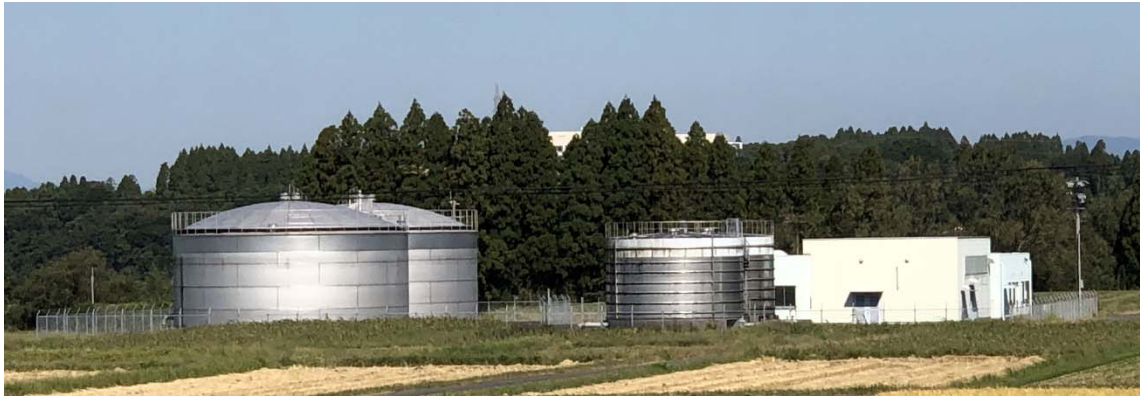
中央浄水場（左から第 4 配水池×2・浄水池×2・電気室） GH+197m ※ 水槽は SUS 構造（円筒形：ステンレス全溶接）
