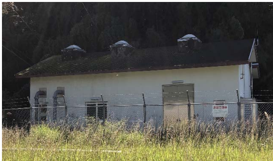
高区加圧ポンプ所 GH+218m
