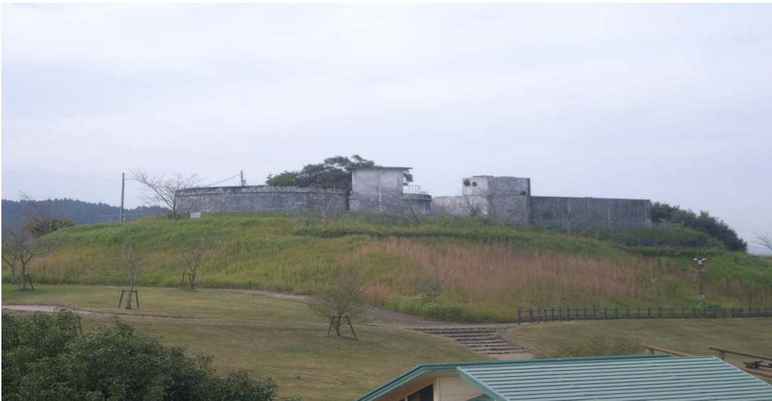
写真下 中央地区 第2配水池（右手前）、第3配水池（左奥）
