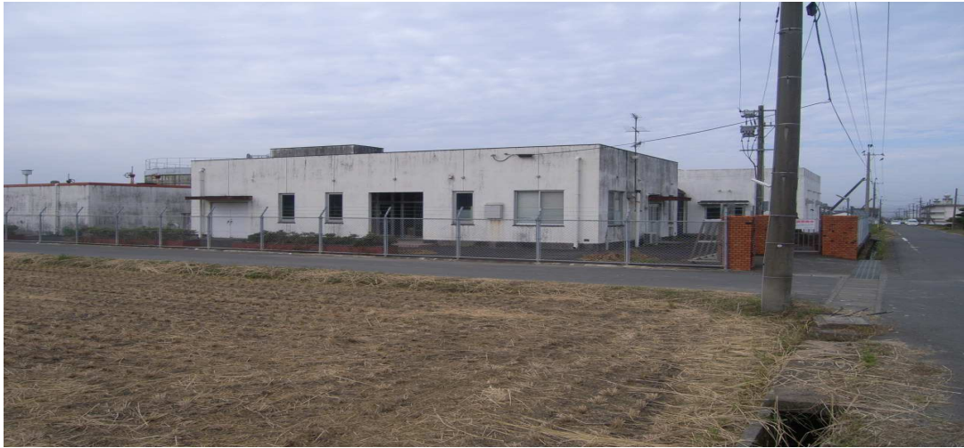
写真上 中央地区 浄水場
