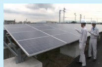
太陽光発電設備の検査の様子
