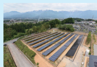
リユース品を使用した発電所
