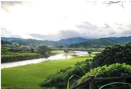
沖水川 三股橋下流
