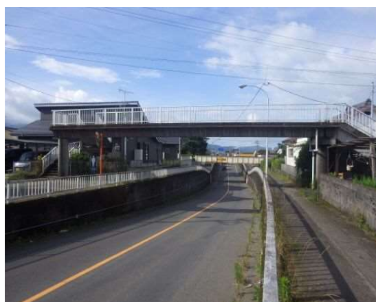
図 9 道路を跨ぐ橋梁の例（三股町管理 三股町横断歩道橋）
