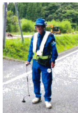
路面音聴調査の様子
