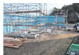
建設中の第6部消防団詰所
