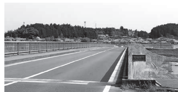
橋梁修繕事業 2,521万円
