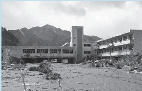
被災した鶏住居(うすのまい)小学校 写真提供: 釜石市
