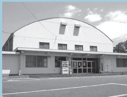
町体育館(昭和39年建設)
