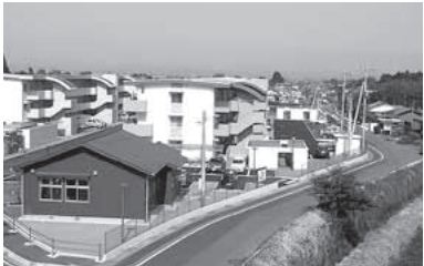
「快適に暮らせるまちづくり」の一環として、平成24年度に建設された鉄筋コンクリート造り3階建ての塚原団地B棟
