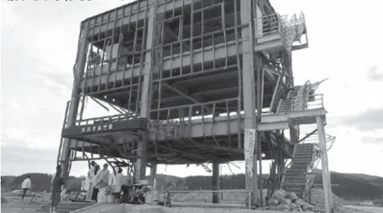
防災対策庁舎には多くの甲問客が訪れます
