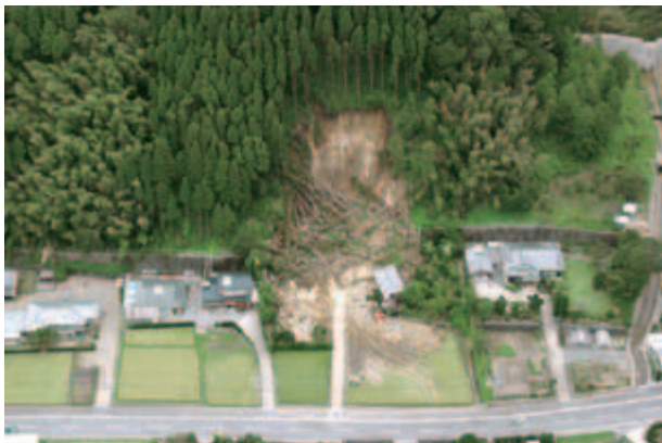
平成17年9月、梶山地区で起きた大規模土砂災害
