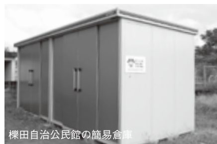
櫛田自治公民館の簡易倉庫
