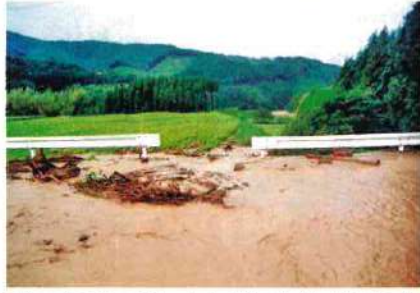
昨年の台風第14号は、町内各地に大きな被害をもたらした(上/寺柱地区、中/上米公園、下/梶山地区)
